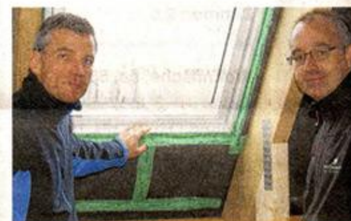
Jan Helge Schröder (li.) und Olaf Henschen bei der Baubegehung
