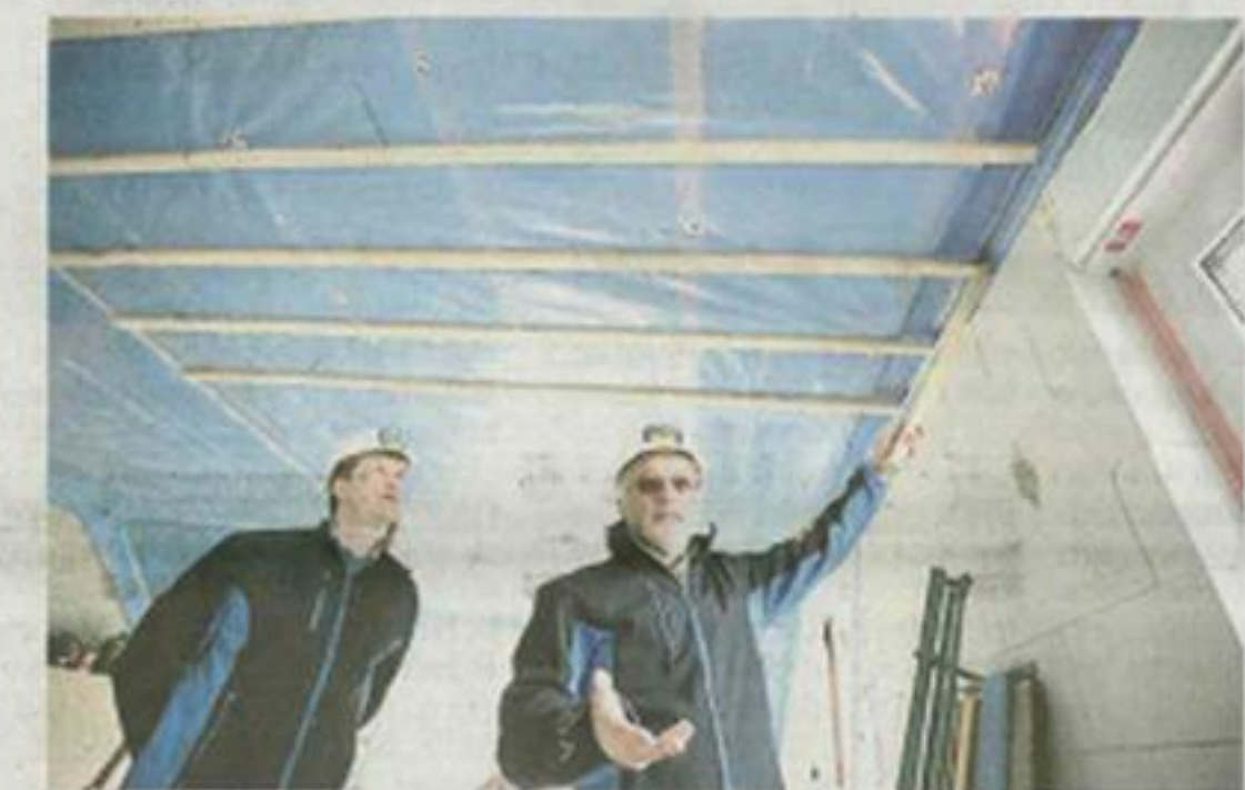
Baukontrolle live: Peter Heiß (l.) und Udo Schumacher-Ritz arbeiten für den VQC – Verein zur Qualitäts-Controlle am Bau.
